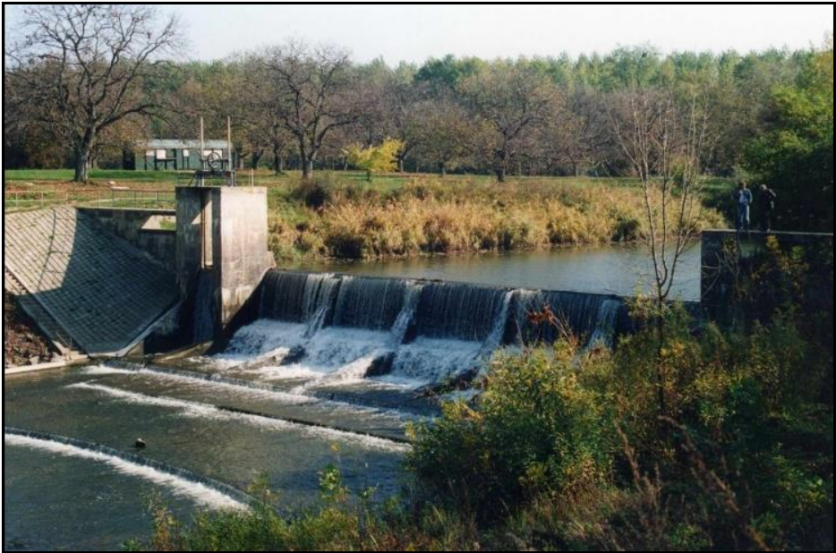
1. kép. A Túr-csatorna torkolati bukólépcsője. Forrás: fetivizig.hu
