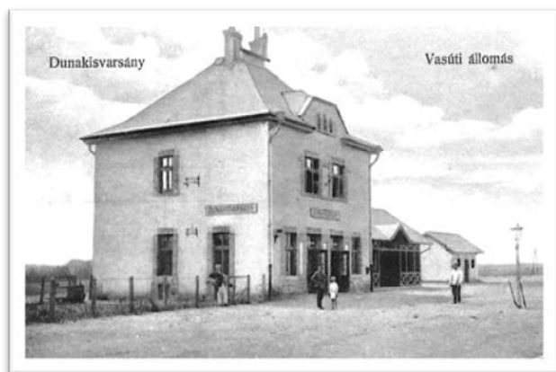
1. kép: Dunakisvarsány új vasút állomása
