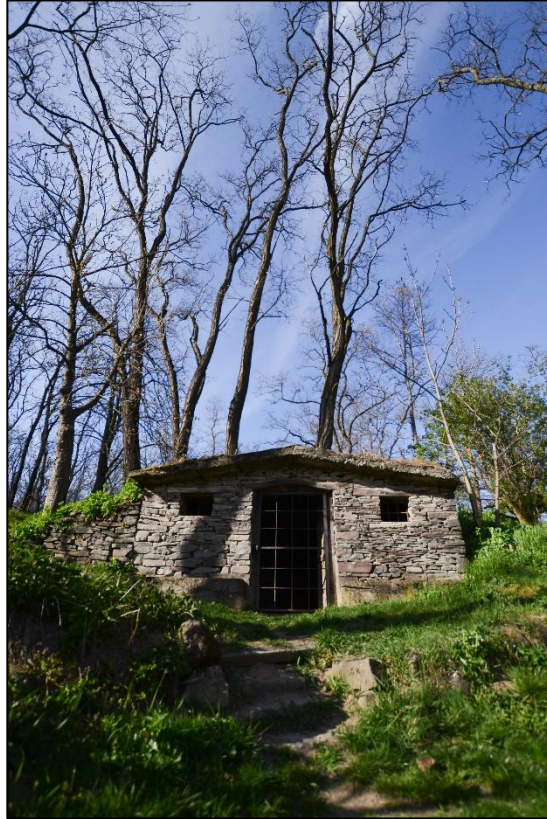
2. kép. Újabb építésű pincék, Kisgéres (Asszonyi E. felv. 2021.)
