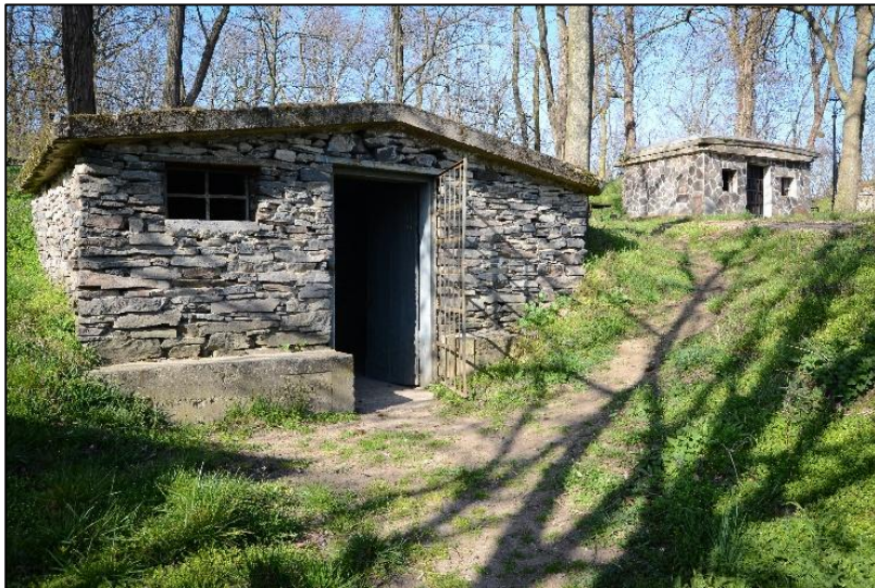
3. kép. Újabb építésű pincék, Kisgéres (Asszonyi E. felv. 2021.)
