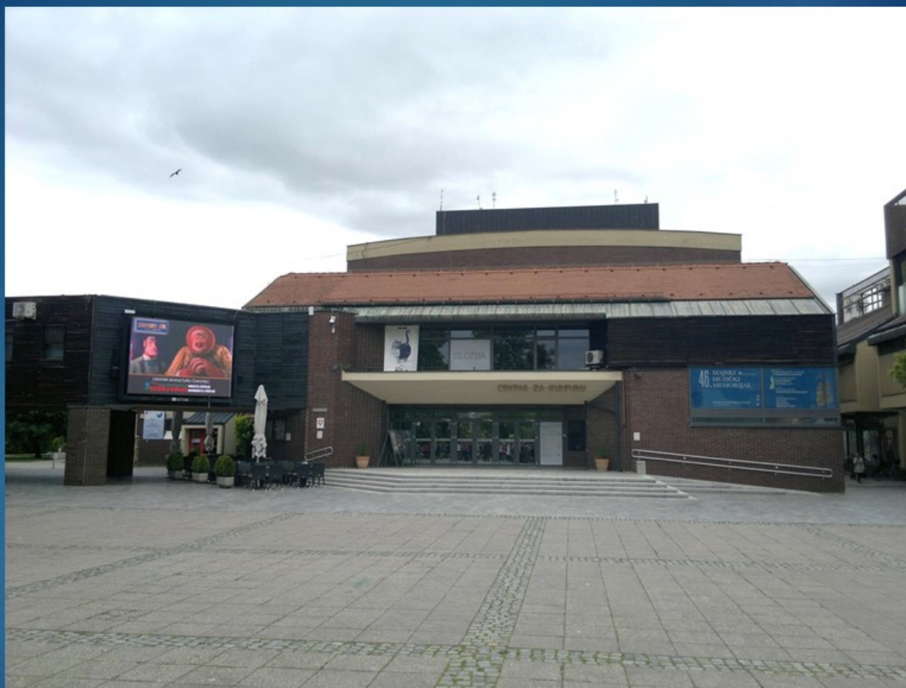
A modern építésű kultúrház Csáktornyán
